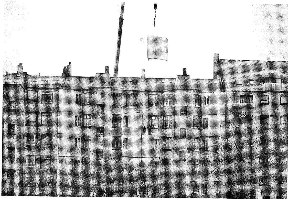
Figur 1. Badetårn under montage
